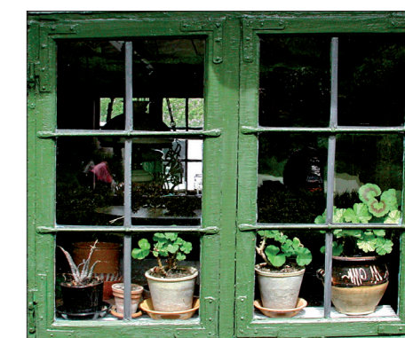
Blysprosset vindue med synlige vindjern
